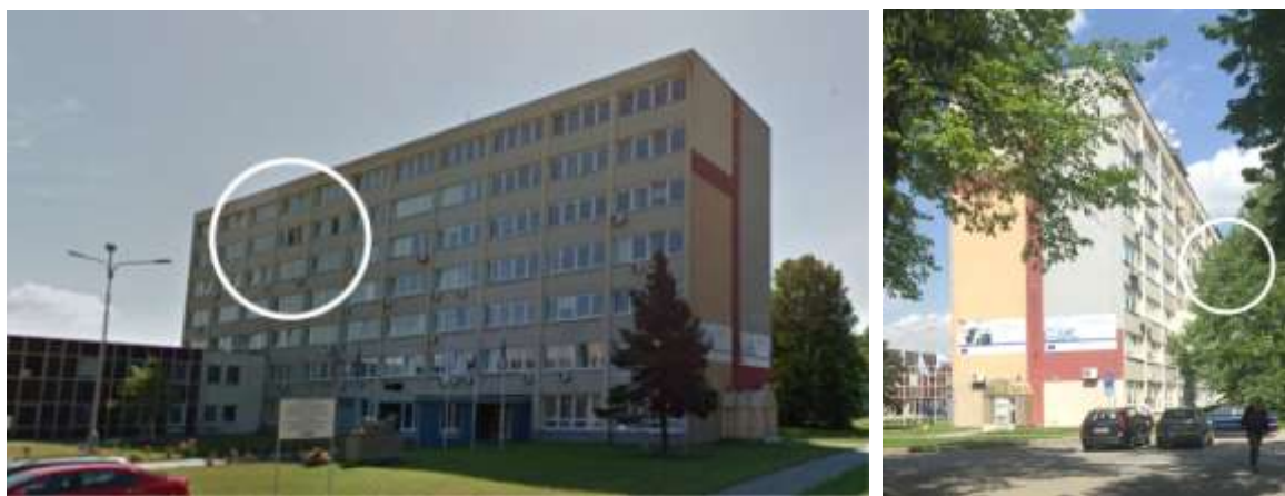
Obr. 42: Pohledy na hlavní administrativní budovu
